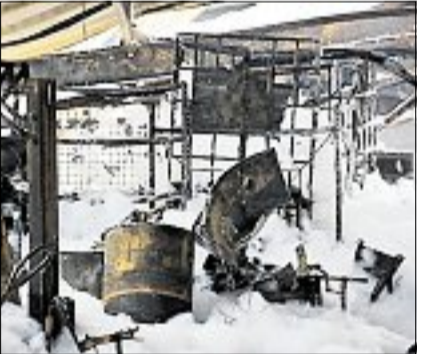
Die Überreste der Lagerhalle in Anderten sind bedeckt mit Löschschaum. Schaarschmidt
